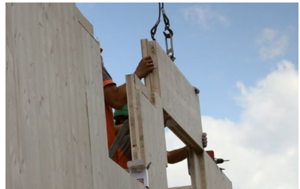
Préparation d'un joint et d'une installation – SOLID 84, 124 mm.
