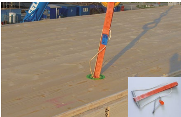
Goujon d'ancrage (4 pièces pour un ELEMENT).
