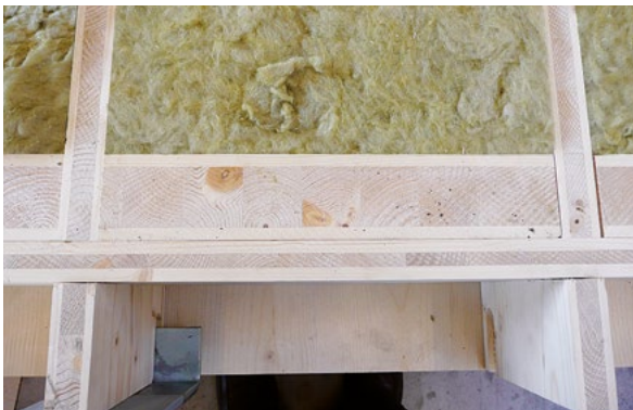
Renforcement en bois massif au point de pression.
