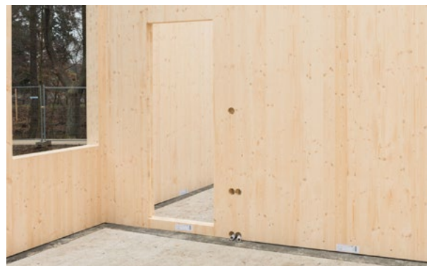
Préparation du câblage électrique à l'intérieur des panneaux sur toute la hauteur des murs.
