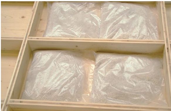
Remplissage de calcaire (40, 60, 80 kg/m 2 )
