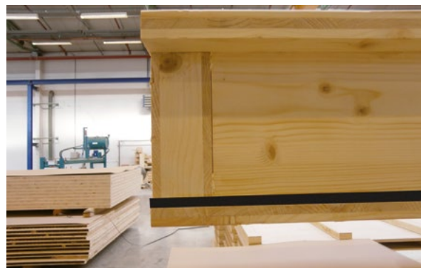
Installation d'une bande coupe-feu dans un joint longitudinal.
