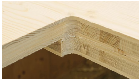
Détail de la finition de la découpe par la fraise – avec rayon (qualité visible).
