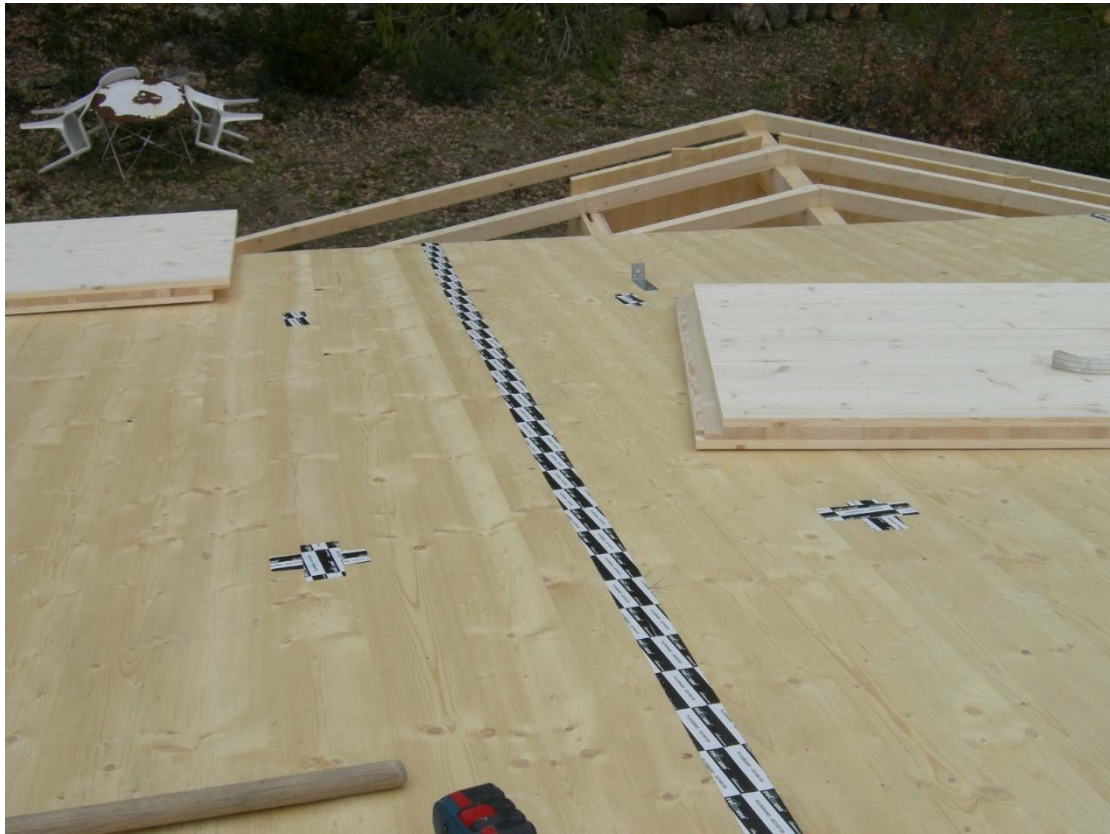
Figure 13 : Pontage des caissons et trous de levage
